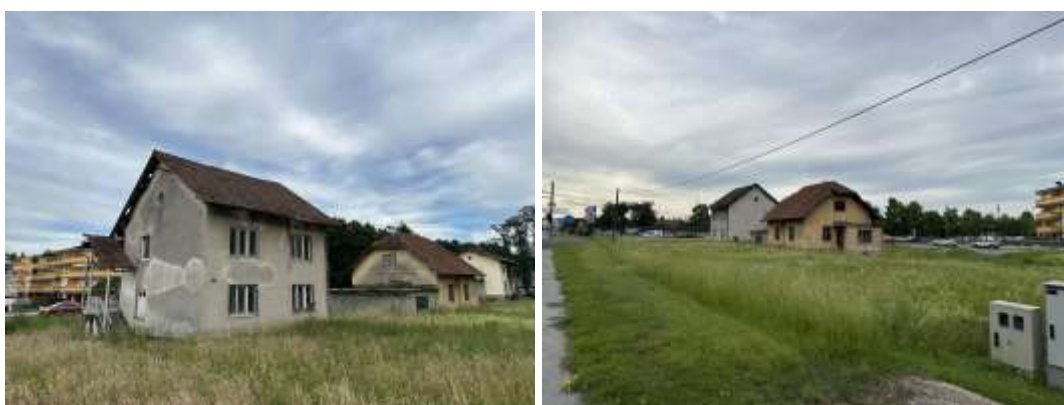
Slika 13: Pogled na obstoječe stanovanjske objekte na jugzahodu, ki se bodo rušili, vir: Urbis d.o.o.
