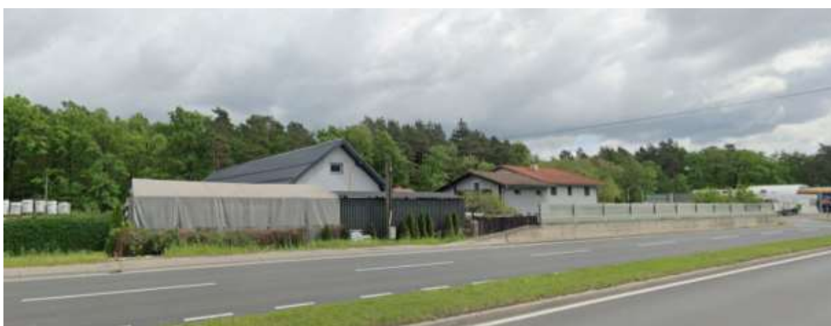
Slika 17: Pogled na obstoječe objekte na jugu s Ptujске ceste, vir: https://www.google.com/maps/
