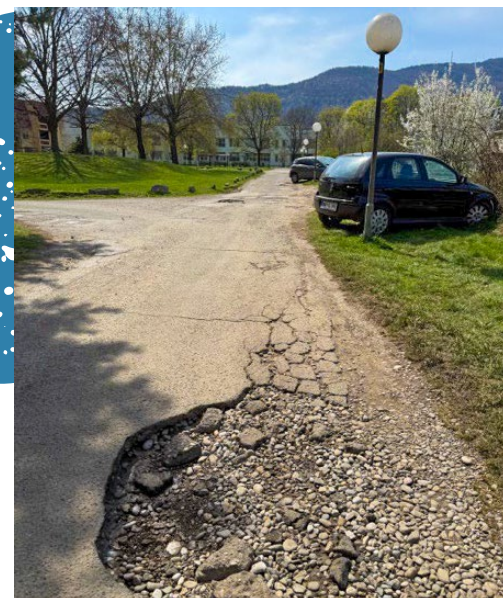
SLIKA 8: PRIMER GLOBOKE UDARNE JAME, KI OGROŽA VARNOST UPORABNIKOV, ZLASTI PEŠCEV IN KOLESARJEV
