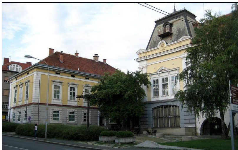
Slika 6: Obstoječ objekt UGM na Strossmayerjevi ulici 6 v Mariboru
