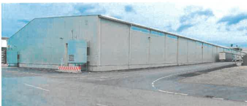
Slika 3: Fotografija sorodnega objekta
