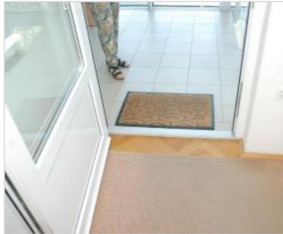
Prehod brez arhitektonskih ovir
