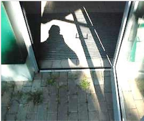
Glavni vhod brez arhitektonskih ovir
