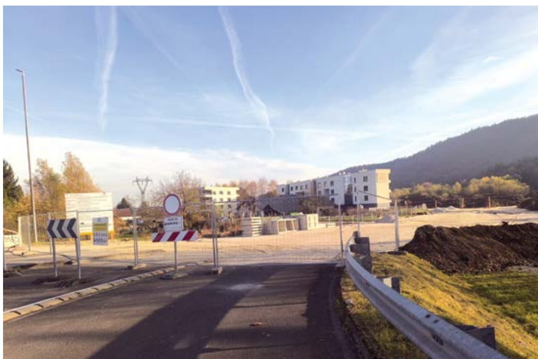
Stekla 1. faza gradnje ti. južne obvoznice
