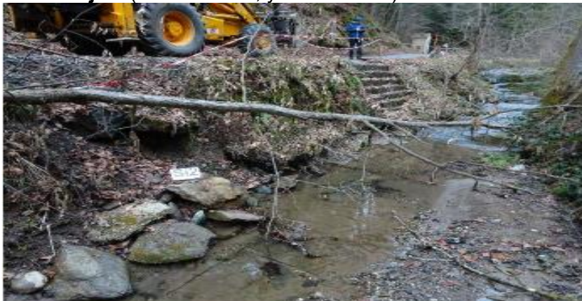
Slika 7 (vir: lasten): Sondažni zasek v brežino Si2
