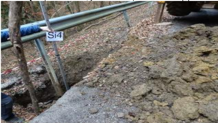
Slika 15 (vir: lasten): Sondažni izkop Si4 in del izkopanega materiala
