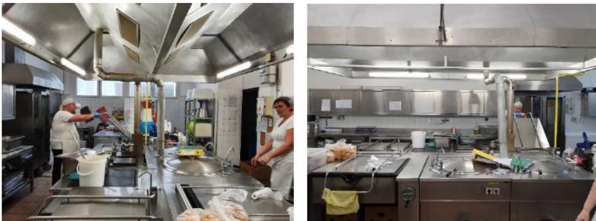
Slika 2: Obstoječe stanje kuhinje na OŠ Leona Štuklja
