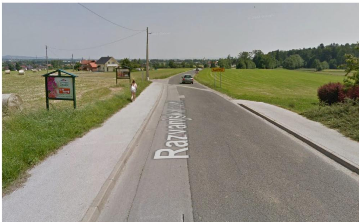
SLIKA 5: OBMOČJE ZAČETKA MEŠANE POVRŠINE IN NAVEZAVA NA OBSTOJEČ PLOČNIK V NASELJU RAZVANJE
