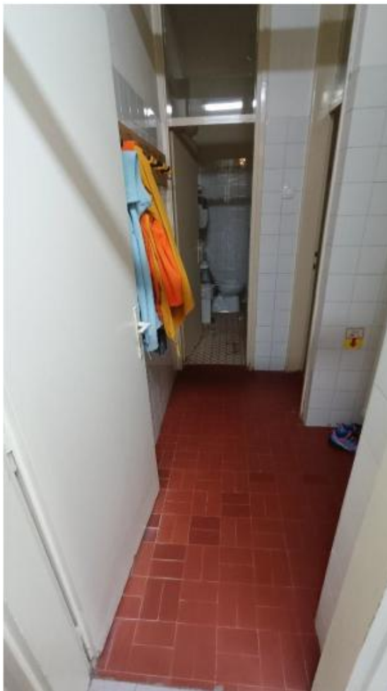
Slika 6: Prikaz trenutnega stanja sanitarij, tuša in predprostora za zaposlene
