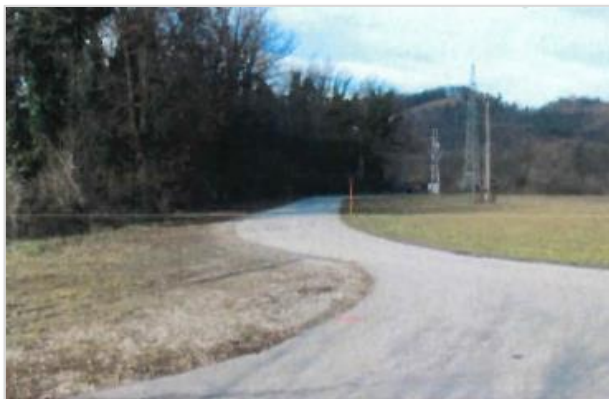
Odsek 1: asfaltna cesta ob Blažovnici
