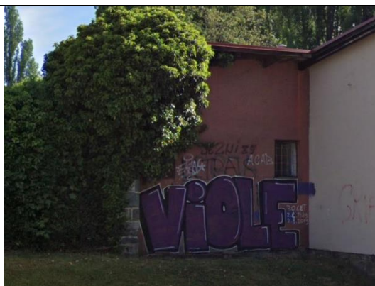
Slika: Pomožni objekt
