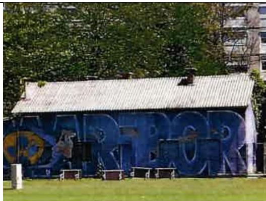
Slika: Pomožni objekt
