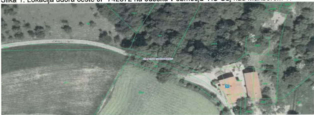
Slika 1: Lokacija udora ceste JP 742572 na odseku v območju HŠ Gaj nad Mariborom 17
