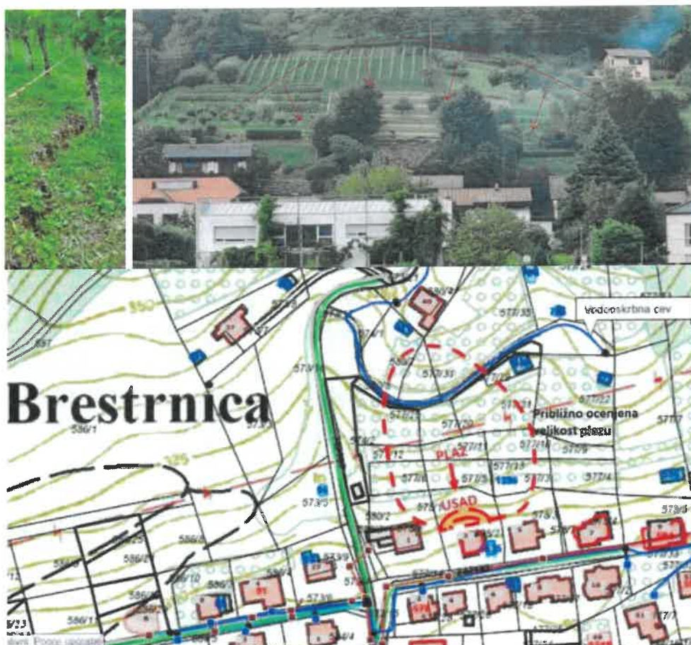
Slika 2-5: Plaz nad stanovanjskimi hišami Pod hribom 1, Pod hribom 3, Pod hribom 5
