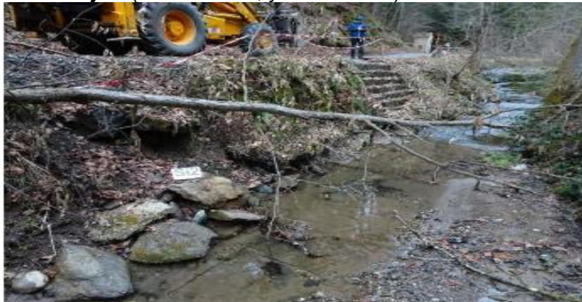
Slika 7 (vir: lasten): Sondažni zasek v brežino Si2
