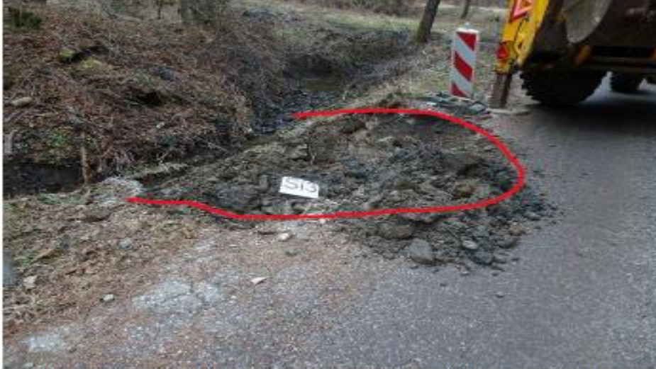
Slika 12 (vir: lasten): Izkopani material iz sondažnega izkopa Si3
