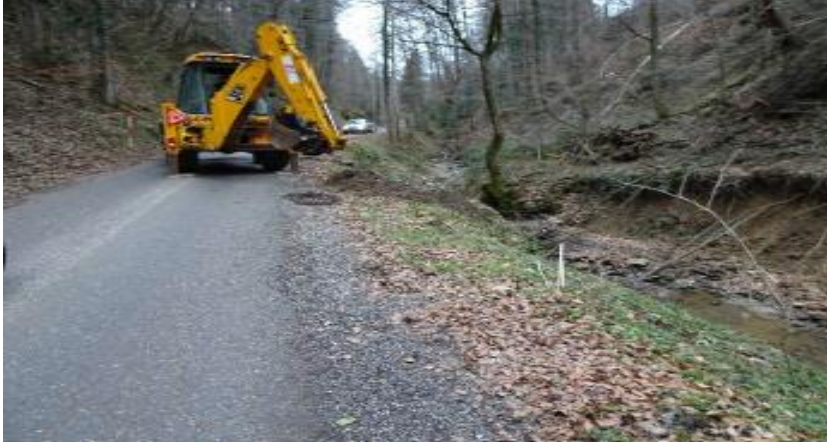
Slika 3 (vir: lasten): Pogled proti lokaciji sondažnega izkopa Si1 in okolica
