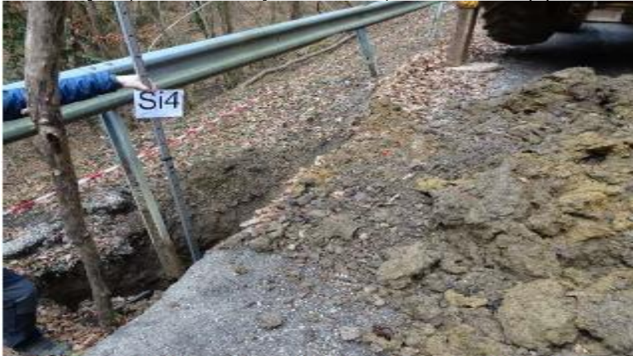
Slika 15 (vir: lasten): Sondažni izkop Si4 in del izkopanega materiala
