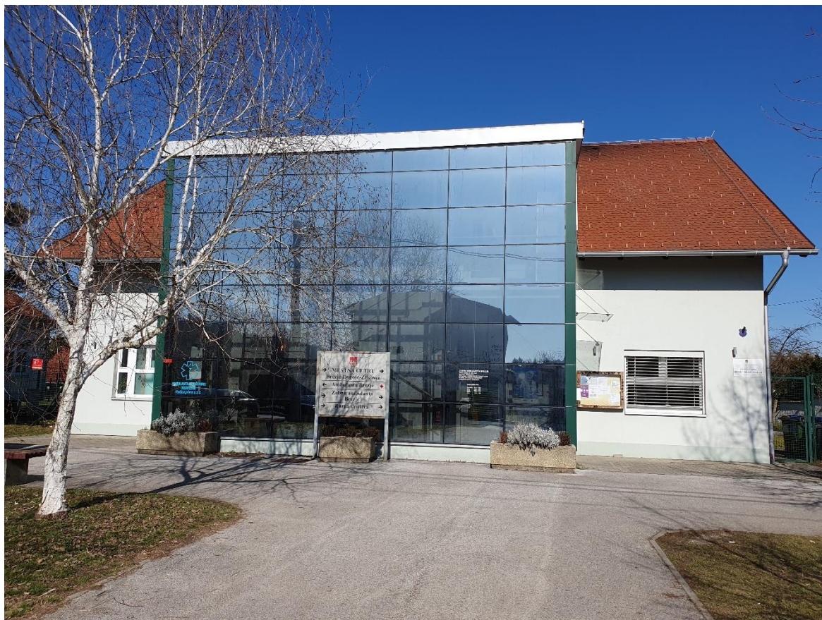
Slika 3: Slika objekta na naslovu Na trati 2
