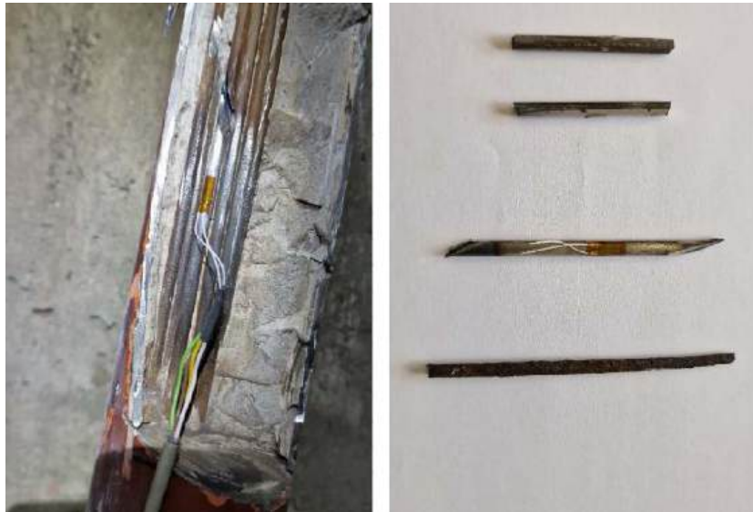
Izvedba preiskav na vertikalnih kablích v oporniku ter odvzeti vzorci kablov
