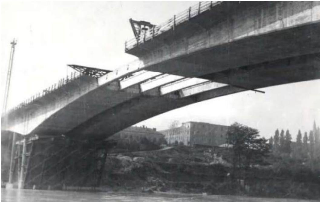
Izvedba vmesne rešetke iz prednapetih nosilcev
