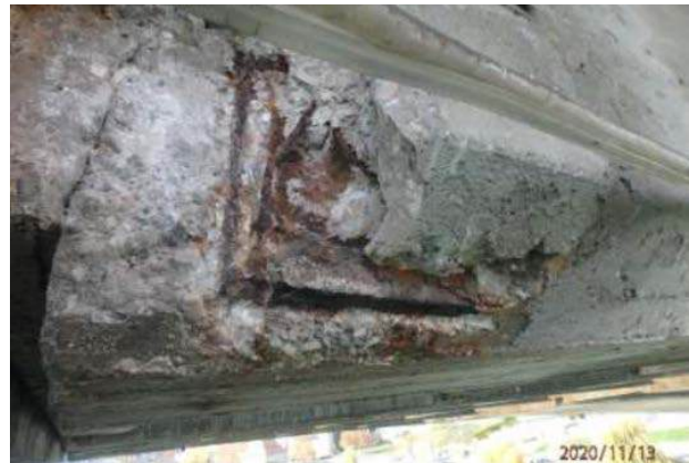
Korozija in poškodovanost nosilcev in kablov vmesne rešetke – vzdolžna nos. (leva slika) / prečna nos. (desna slika)
