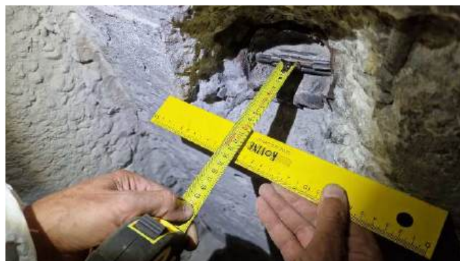
Slika 5: Položaj kabla (oddaljenost od površine)
