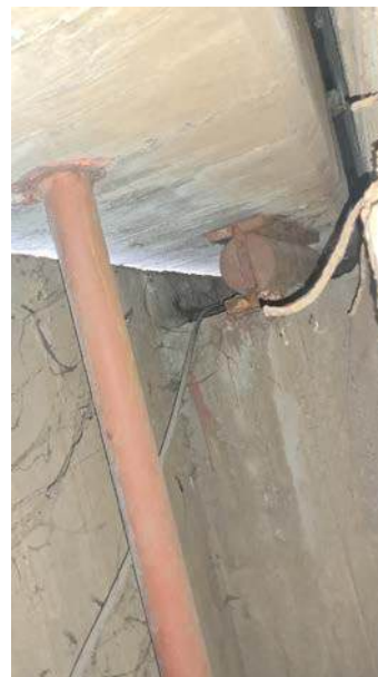
Primer poškodovanih (leva slika) in nepoškodovanih (desna slika) ležišč in prednapetih sider
