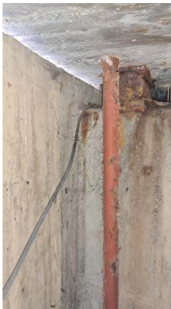
Primer poškodovanih (leva slika) in nepoškodovanih (desna slika) ležišč in prednapetih sider
