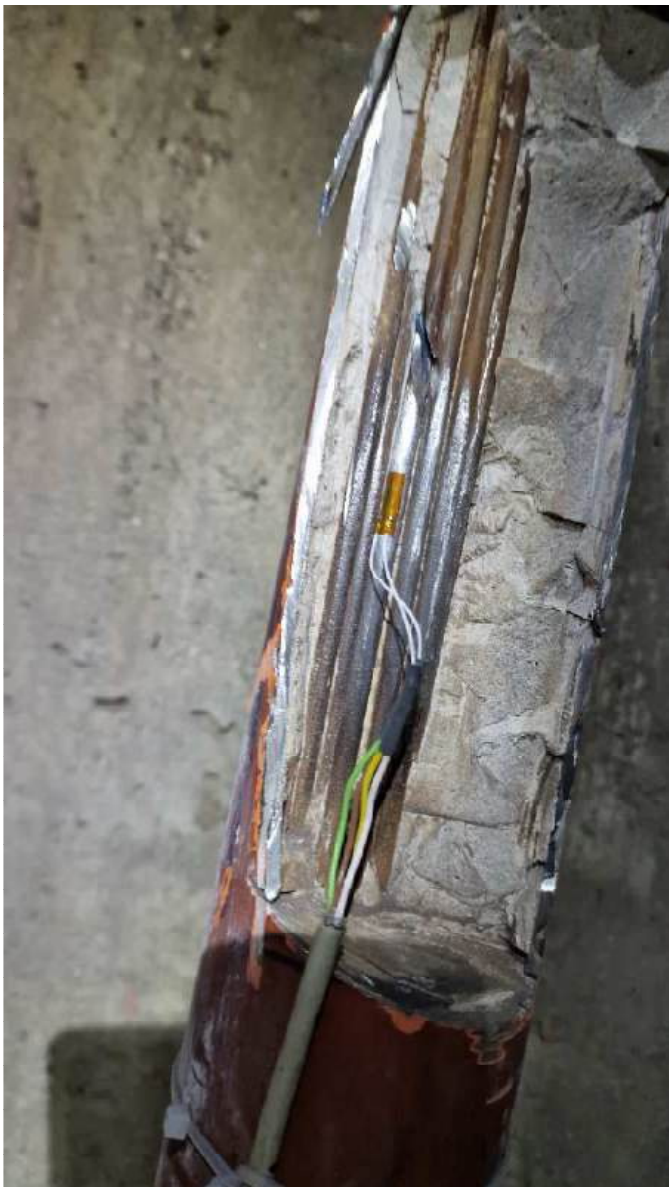
Slika 8: Merilni listič nalepljen na eni od očiščenih žic vertikalnega kabla v oporniku po izvedbi testa
