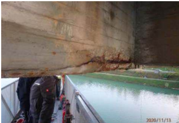
Korozija in poškodovanost nosilcev in kablov vmesne rešetke – vzdolžna nos. (leva slika) / prečna nos. (desna slika)
