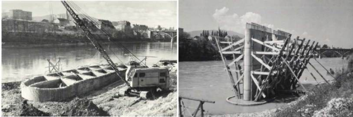
Izvedba temelja in rečnega stebra na severni strani
