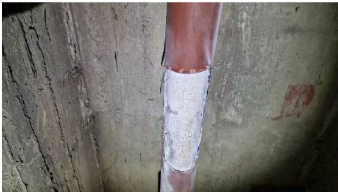
Slika 6: Vertikalni kabel v oporniku, na katerem je odstranjen del zaščitne cevi
