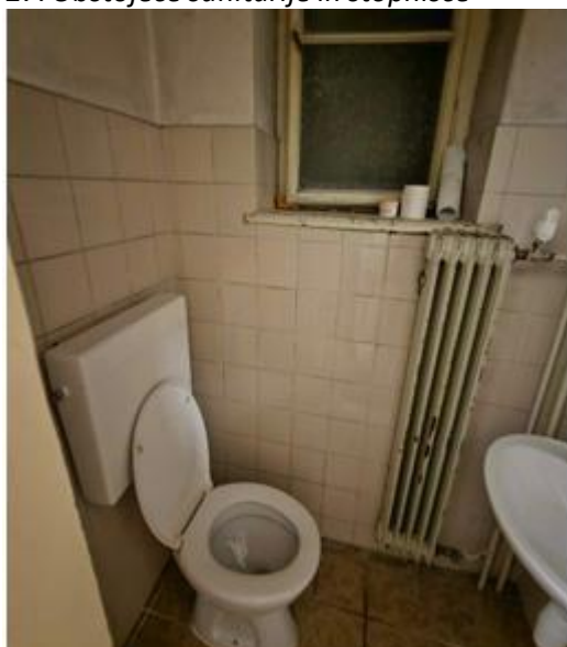
Slika 27: Obstoječe sanitarije in stopnišče
