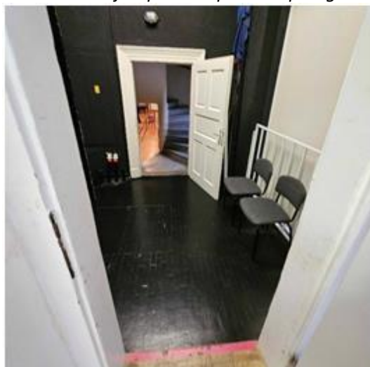
Slika 31: Obstoječi prostori prenove prvega nadstropja
