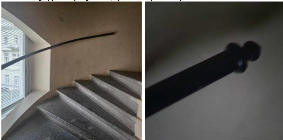
Slika 18: Fotografija obstoječega rokooprijema in zaključka ročaja
