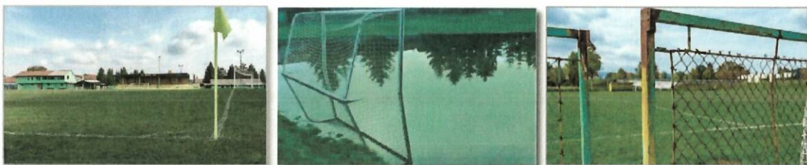
Slika 1: Neravna travna površina, zastajanje meteorne vode in dotrajane ograje (Vir: arhiv NK Pobrežje, Lokalec.si, februar 2023)
