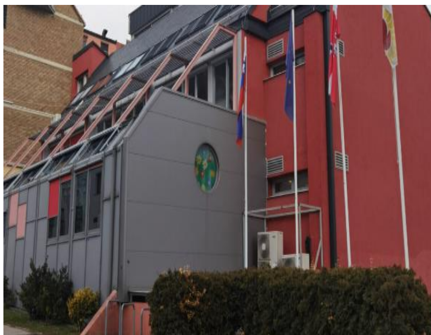
Slika 3.40: Objekt Vrtec Ivana Glinška uprava
