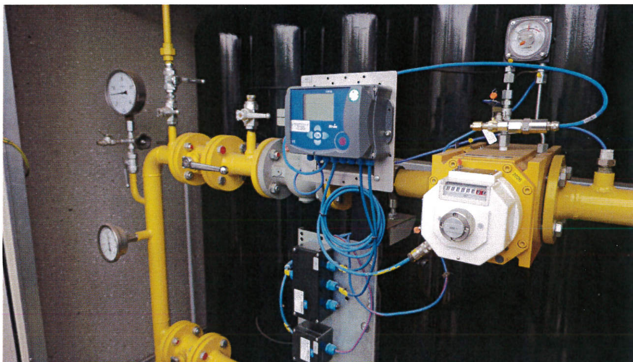
Slika 8: Merilna postaja – plinovod
