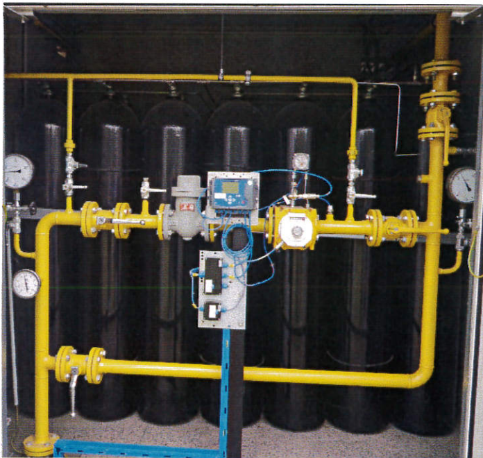
Slika 7: Visokotlačni zalogovnik (črne jeklenke)
